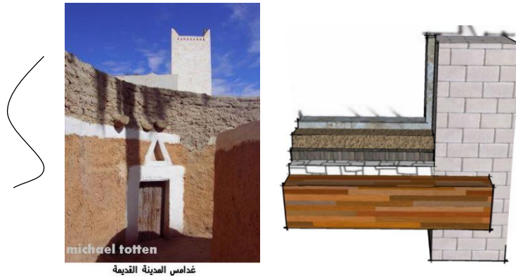
شكل رقم (3) يوضح استخدام جذوع النخيل كمادة رئيسية في الانشاء وصناعة العناصر الخشبية_ غدامس (الباحث).
